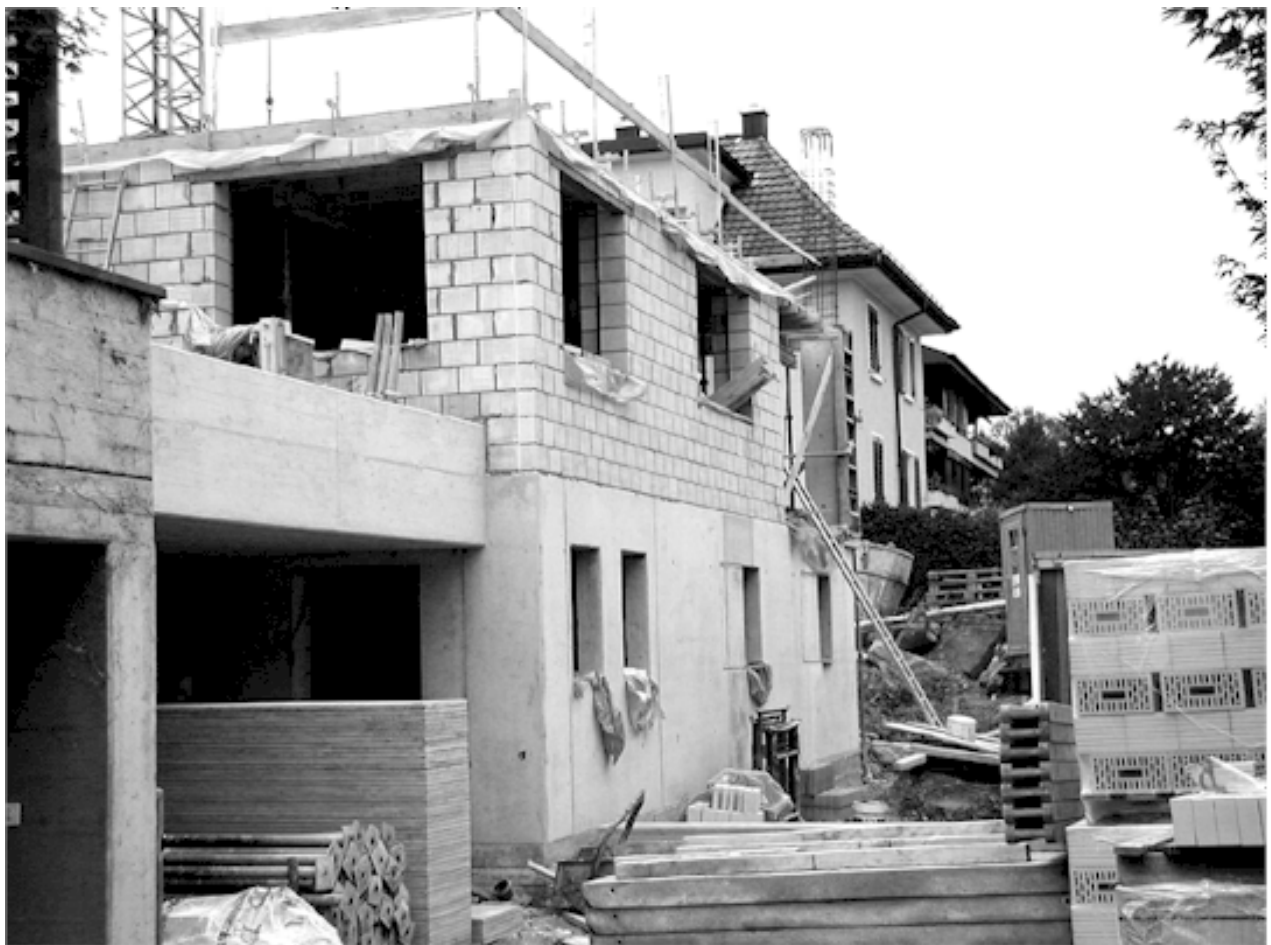
Baustelle an der Ringstrasse
